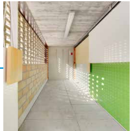
Ingang garage Confortalei
